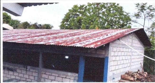
Foto 4: Se observa el deterioro del techo del modulo de cocina se necesita remocion de laminas.
