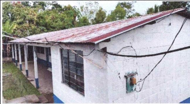
Foto1: Se observa el deterioro del techo se necesita remocion de láminas en el modulo 1
